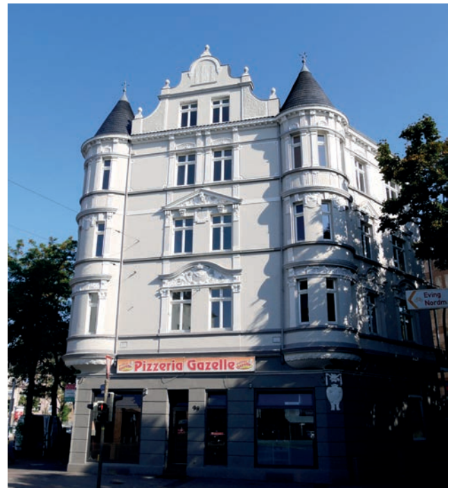
Abb. 38: Mit Unterstützung durch Städtebauförderungs-mittel saniertes Gründerzeitgebäude in der Dortmunder Nordstadt
