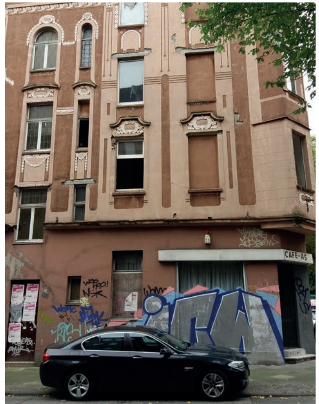
Abb. 16: Problemimmobilie in der Dortmunder Nordstadt
