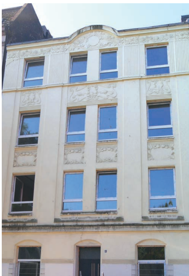
Abb. 37: Durch Ansprache wurden Sanierungsmaßnahmen in einem Gründerzeitgebäude in der Dortmunder Nordstadt initiiert
