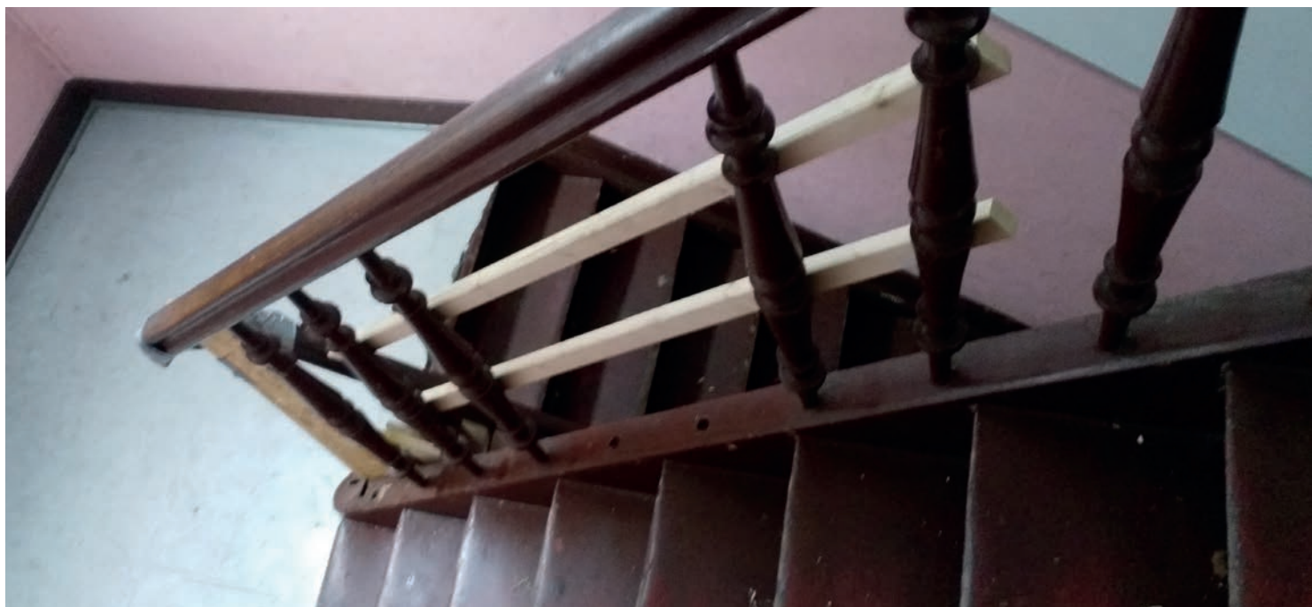
Abb. 21: Typischer Missstand: nicht funktionstüchtige Treppengeländer
