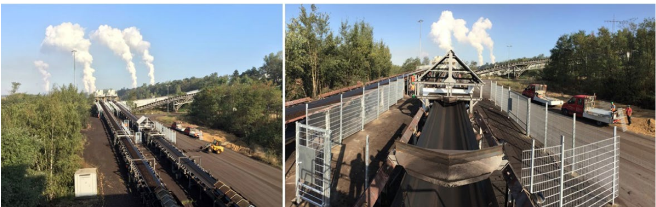
Bild 8.2 – Installationsort eines PGNAA-Analysators (Coalscan) im Bunker Fortuna (Bandanlage N123) des Tagebaus Garzweiler. Die Anlage wurde um einen Zaun und einen Brockenabweiser erweitert.
