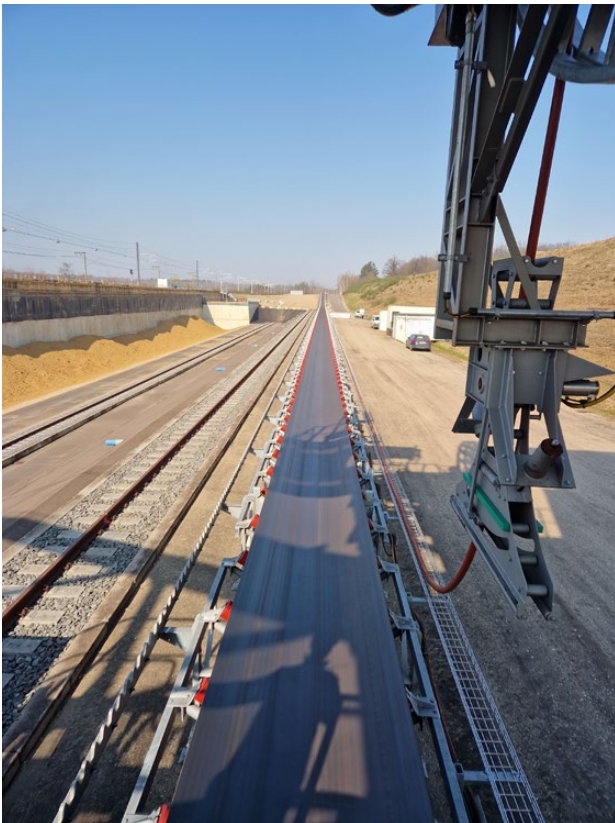
Bild 5.2 – Bandanlage im Bereich des Lössbunkers (Quelle: Bezirksregierung Arnsberg)
