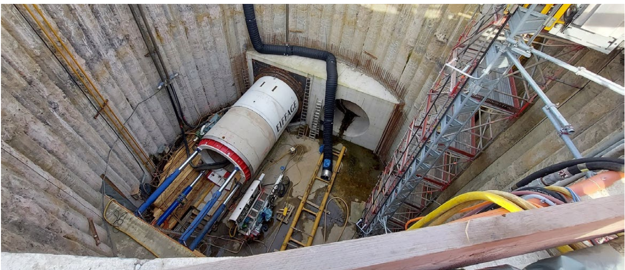
Bild 9.3 – Die Tunnelbohrmaschine in der Startgrube (Quelle: Bezirksregierung Arnsberg)
