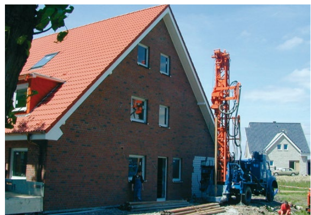
Bild 2.2 – Geothermiebohrung (Quelle: Bezirksregierung Arnsberg)
