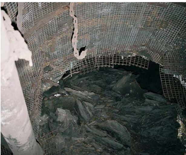
Bild 7.3 – Aufnahme von Norden (Quelle: RAG Anthrazit Ibbenbüren GmbH)
