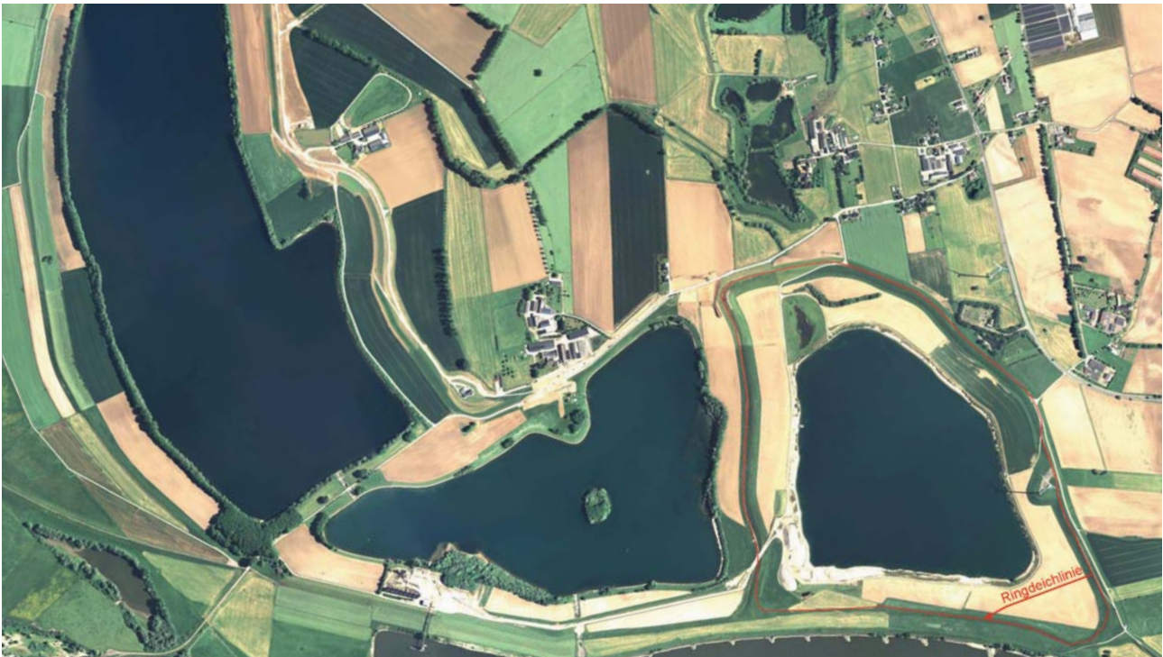
Bild 2.1 – Rückhalteraum Lohrwardt (Quelle: Fa. Hülskens GmbH & Co. KG)
