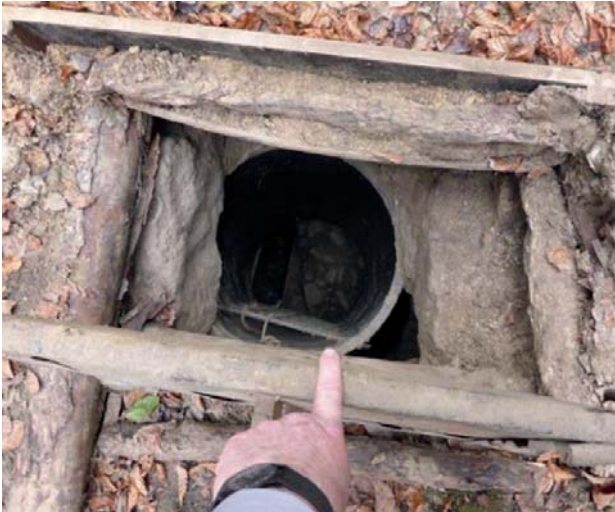
Bild 10.7 – Dützerstollen (Grube Porta), wilde Grabung
