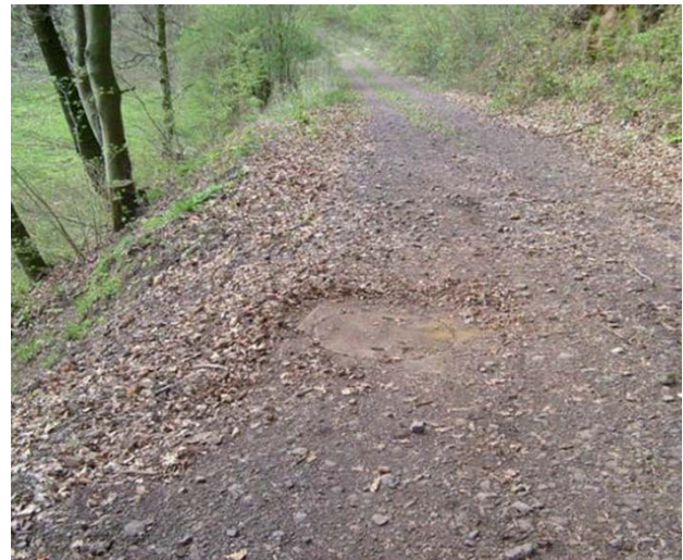
Bild 10.10 – Wittekindstollen, wilde Grabung im Verkehrsbereich
