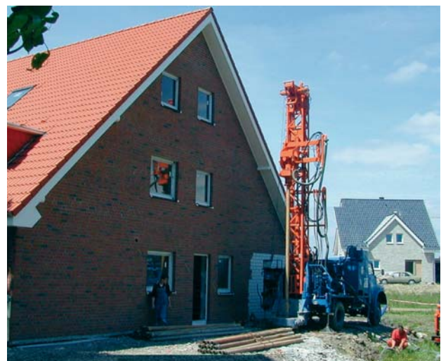
Bild 1.2 – Geothermiebohrung (Quelle: BR Arnsberg)
