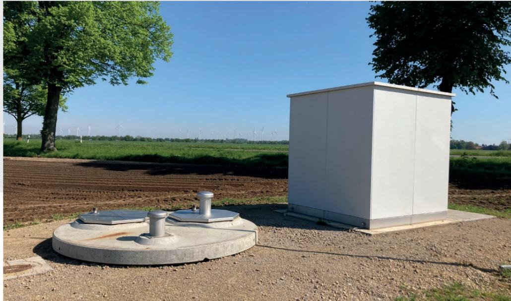
Abbildung 11: Überbetriebliche Bewässerungsinfrastruktur: Zentrale Brunnenanlage mit leistungsstarker Pumpe und zugehörigem Transformator (Quelle: Bellinghausen/LWK).
