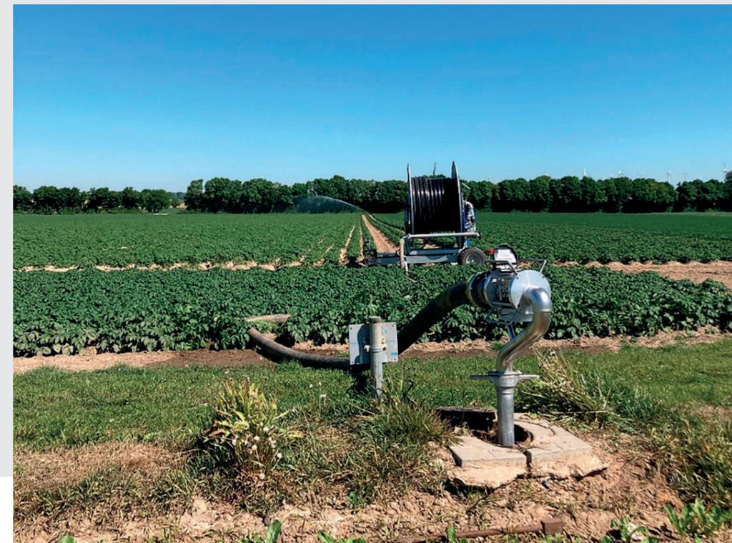
Abbildung 13: Entnahmepunkt zur Bewässerung aus der Ringleitung im Projektgebiet Pütz
