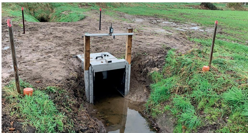
Abbildung 9: Digital steuerbares Kippwehr zum Anstauen des Vorfluters im Rahmen des NiersCon-Projektes am Niederrhein (Quelle: Kreis Viersen).
