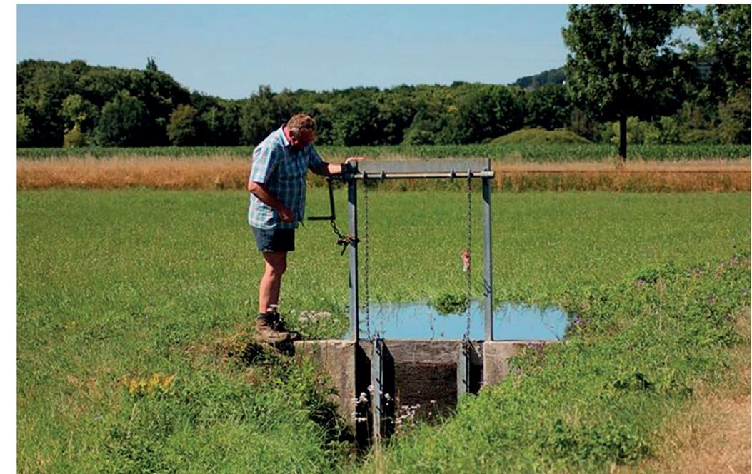
Abbildung 8: Die s. g. Wässerwiesen sind eine jahrhundertealte Bewirtschaftungspraxis in Franken. Durch verstellbare Wehre wird kleinräumig der Grundwasserspiegel angehoben, um höhere Grünlanderträge zu erzielen. Diese Technologie ist im Verzeichnis der immateriellen Kulturgüter der UNESCO gelistet (Quelle: UNESCO).
