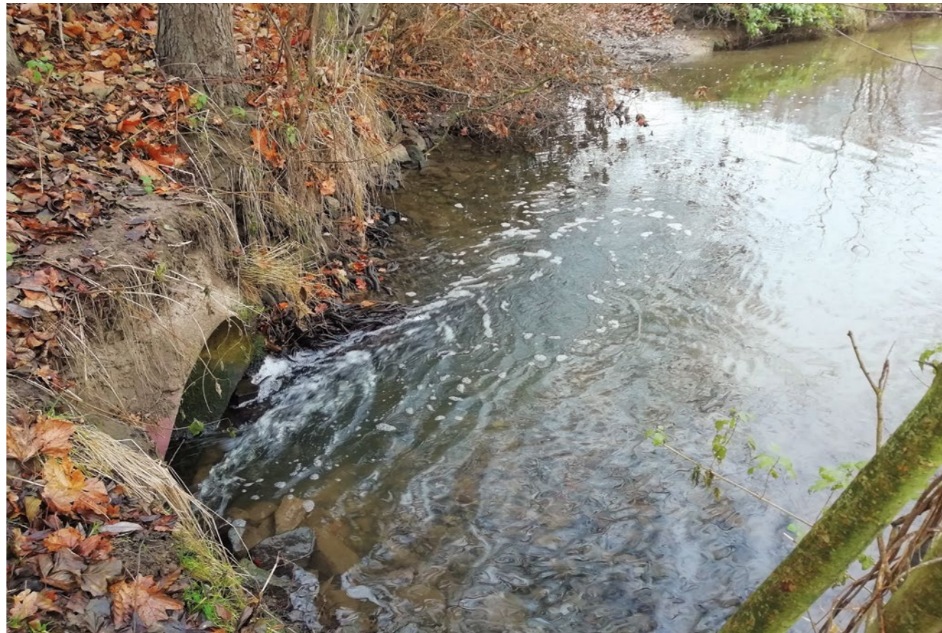
Einleitstelle der Kläranlage Enger in den Brandbach
