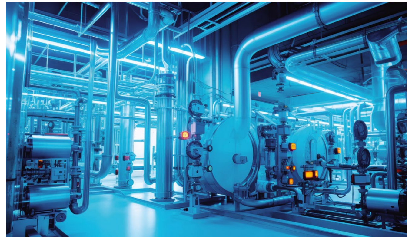
Anlage zum Extrahieren von Wasserstoff aus Wasser mithilfe von Strom, der von Windturbinen und Sonnenkollektoren erzeugt wird.
