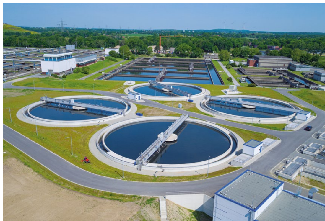
Vier Rundklärbecken der Kläranlage Emscher-Mündung in Dinslaken
