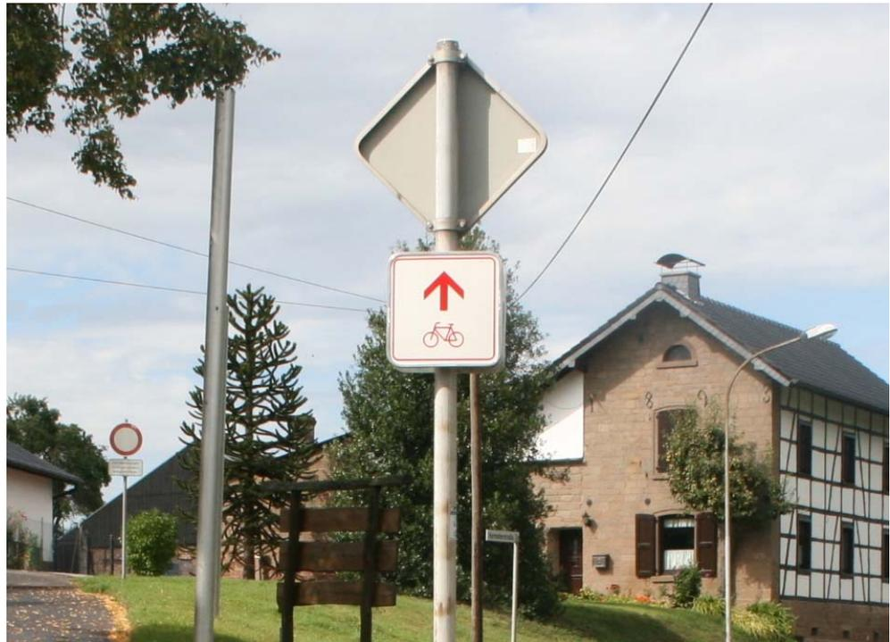
Abb. 3-17: Zwischenwegweiser (Quelle SVK)
