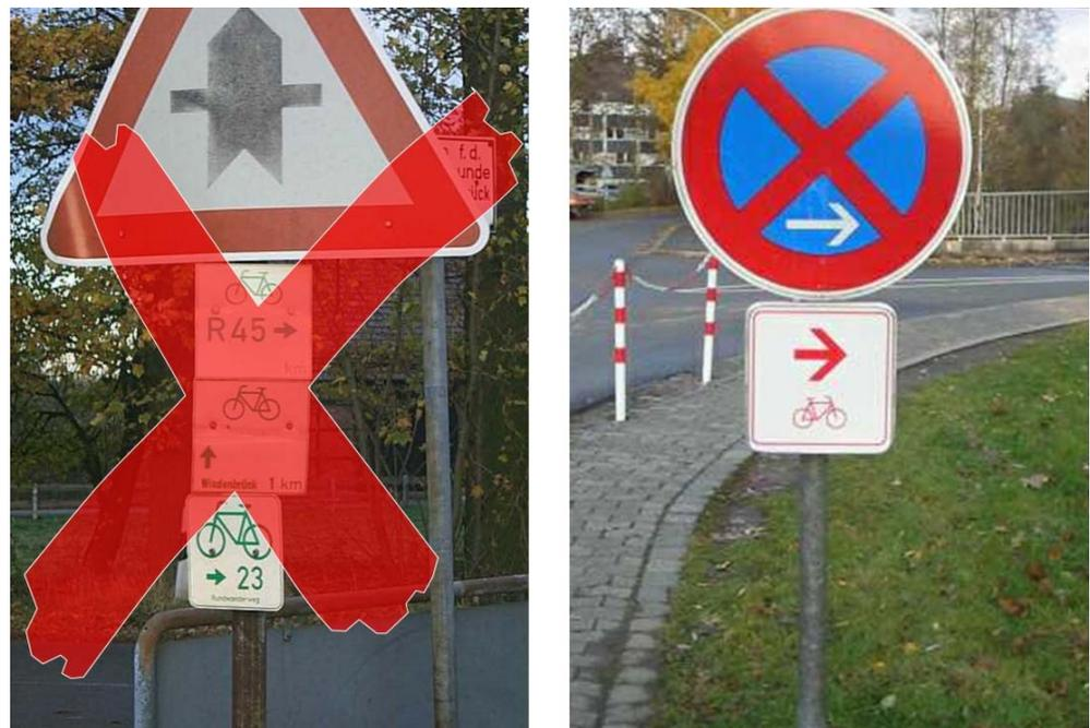
Abb. 4-2: Beispiele für Befestigungen von Wegweisern in Kombination mit StVO-Schildern: Abb. links - verboten / Abb. rechts – zulässig (Quelle: IVV)
