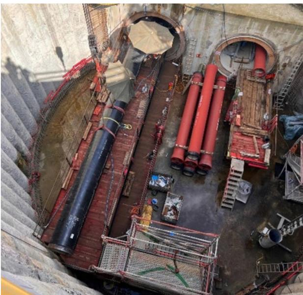
**Bild 7.4** – Portale zum Düker DN 2800 und DN 3200 (Quelle: Bezirksregierung Arnsberg)
