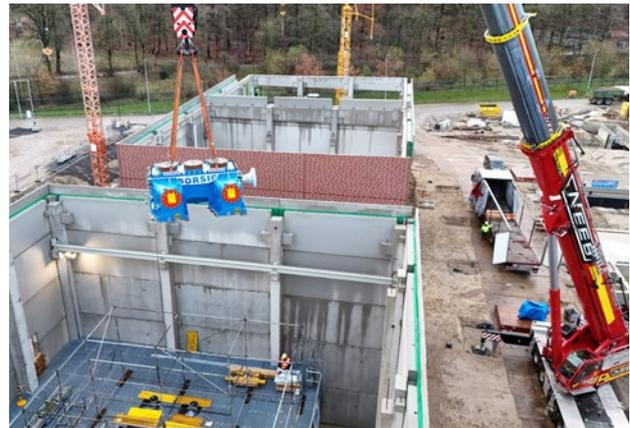
**Bild 8.5** – Einheben des Verdichters
