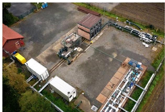
**Bild 8.7** – Flutungsanlage auf dem Kavernenplatz
