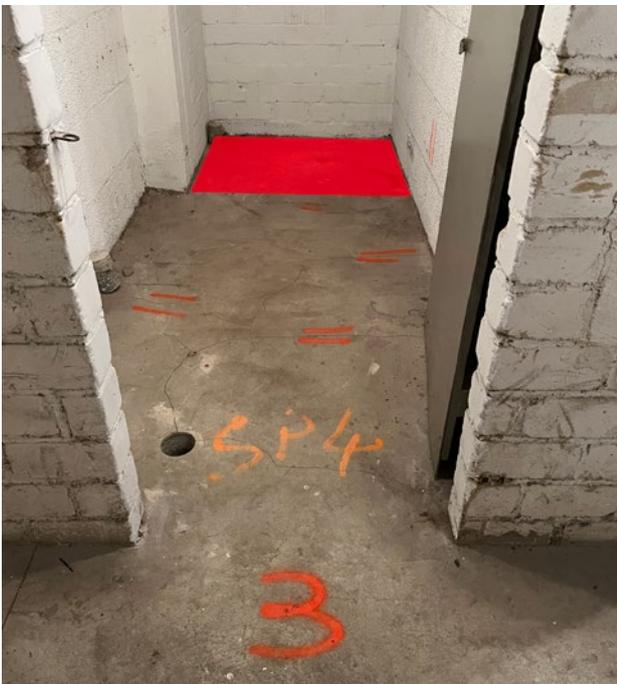
**Bild 12.2** – Lokalisierter Schachtkopfbereich (rot) in einem der Einzelkellerräume (Quelle: Bezirksregierung Arnsberg)
