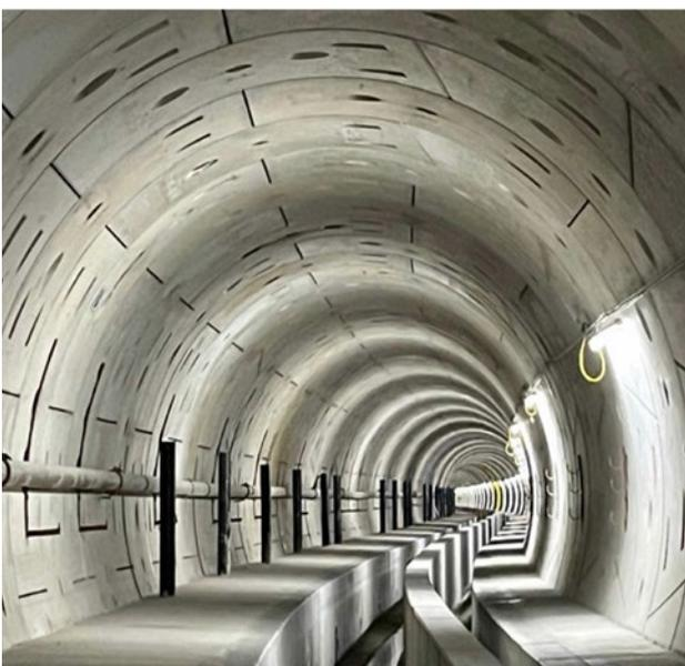
**Bild 7.1** – Ausgebauter Grubenwasserkanal mit Gerinnefertigteilen und betonierten Bermen (Quelle: RAG AG)
