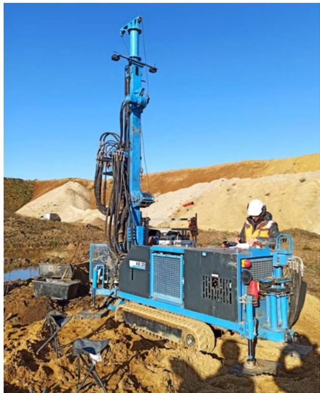
**Bild 6.2** – Durchgeführte Bohrung mit Hohlbohrschnecke (Quelle: Bezirksregierung Arnsberg)
