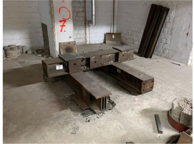
**Bild 12.7** – Einsatzbereites Stahlpfahlfundament (Quelle: Bezirksregierung Arnsberg)
