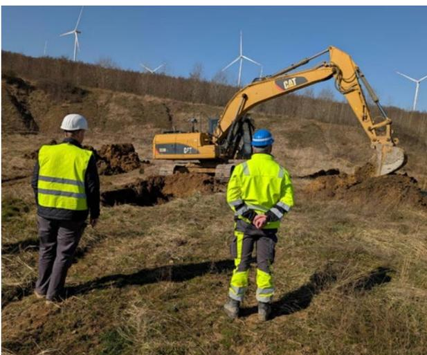
**Bild 6.3** –Anlage eines Baggerschurfes (Quelle: Bezirksregierung Arnsberg)
