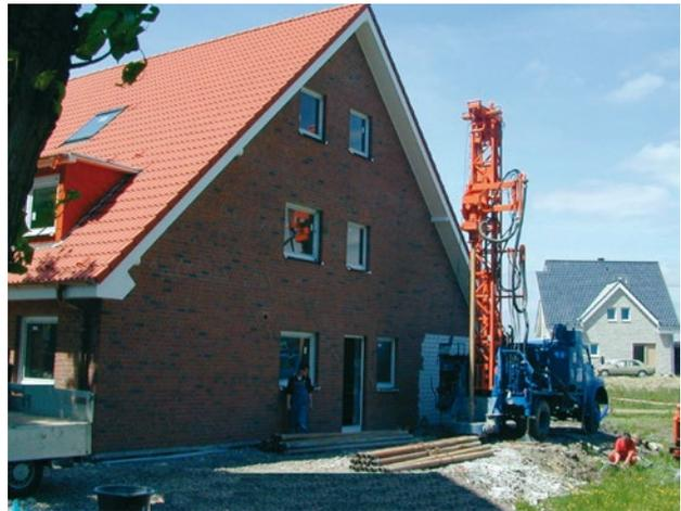
**Bild 2.1** – Geothermiebohrung
