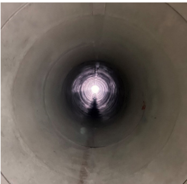
Bild 6.5 – Blick in den Düker DN 3200 (Quelle: Bezirksregierung Arnsberg)
