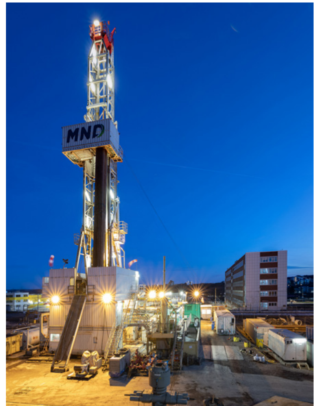
Bild 1.2 – Tiefbohranlage beim Erstellen der Bohrung GT-1 in Bochum, Mark 51°7 Gelände, zur Erschließung von warmem Grubenwasser (Quelle: Felix Jagert)
