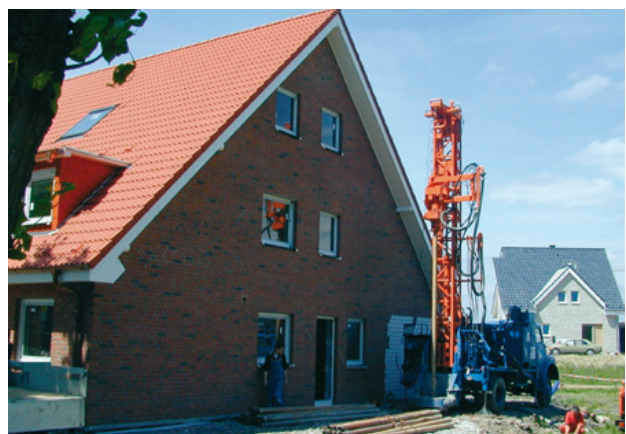
Bild 2.2 – Geothermiebohrung (Quelle: Bezirksregierung Arnsberg)
