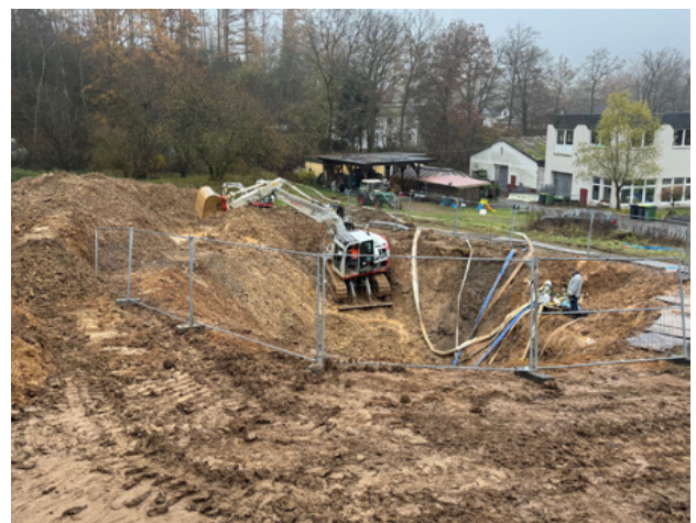
Bild 1.4 – Baugrube im Bereich der Sicherungsarbeiten an der Tagesoberfläche (Quelle: Bezirksregierung Arnsberg)
