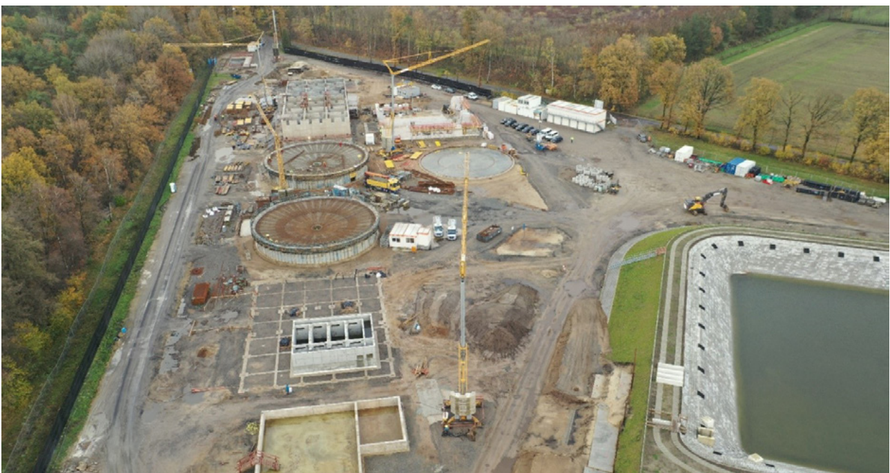
Bild 6.3 – Bau der Grubenwasseraufbereitungsanlage Gravenhorst (Quelle: RAG AG)
