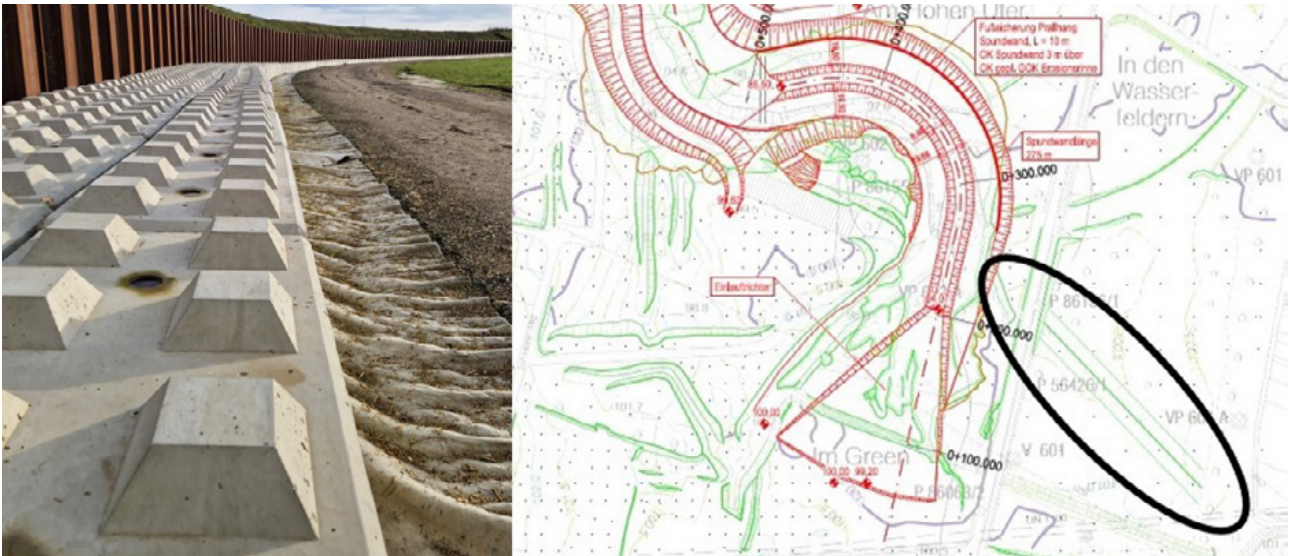
Bild 3.5 – links: Betonsteine vor Spundwand, rechts: Plan zu technischer Sicherung der Erosionsrinne (Quellen: links: Bezirksregierung Arnsberg /rechts: Auszug Sonderbetriebsplan RWE Power AG)
