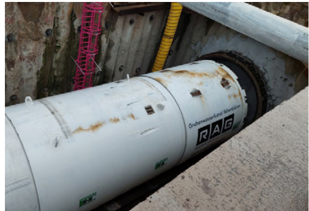
Bild 6.1 – Startschacht am Auslaufbauwerk mit TBM während der Montage (Quelle: RAG AG)
