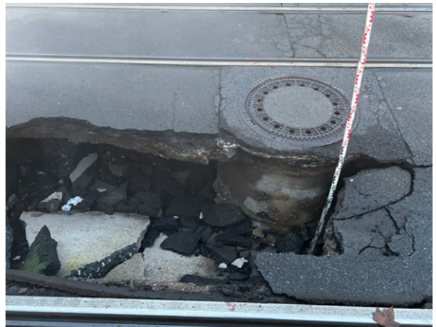
Bild 1.7 – Tagesbruch, wie vorgefunden, an der Hattinger Straße in Bochum (Quelle: Bezirksregierung Arnsberg)
