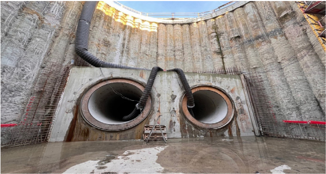
Bild 6.4 – Portale zum Düker DN 2800 und DN 3200 (Quelle: Bezirksregierung Arnsberg)
