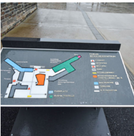
Unterfahrbarer, kontrastreicher Tastplan im Innenhof eines Museums, eingebunden ins Leitsystem
