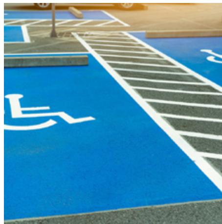
Großflächige Kennzeichnung von barrierefreien PKW-Stellplätzen und der Sperrfläche dazwischen
