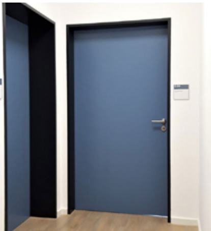
Kontrastreiche Gestaltung von Wand, Boden, Türrahmen, Türblatt, Drücker, Türschild und Lichtschalter
