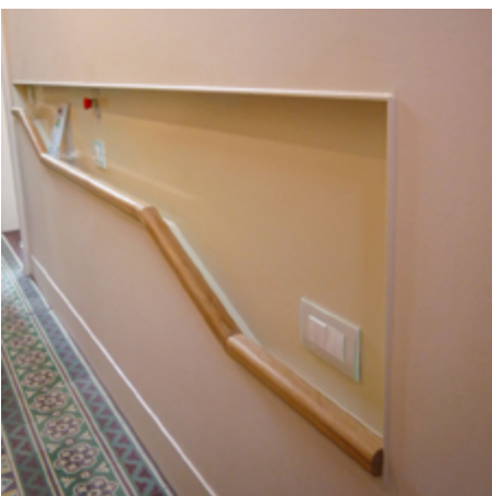
Platzsparend in die Wand eingelassener Handlauf in einem Altbau
