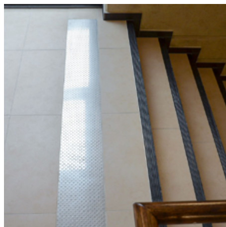
Ein Aufmerksamkeitsfeld aus Tränenblech an einer Treppe ist taktil ausreichend tastbar.
