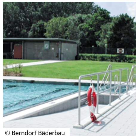
Die flache Rampe erzeugt einen erhöhten Beckenrand.
