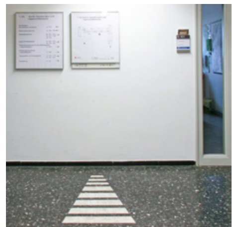
Ein Aufmerksamkeitsfeld als Insellösung führt im Hauptflur zum taktilen Orientierungsplan der Etage.
