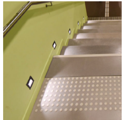
Blendfreie seitliche Beleuchtung der Stufen auf Höhe der einzelnen Stufen
