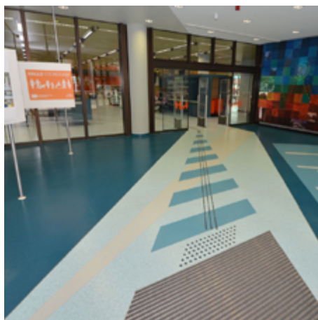
Die kontrastreiche Gestaltung des Linoleumbelags und die aufgeklebten Leitstreifen leiten zum Eingang.
