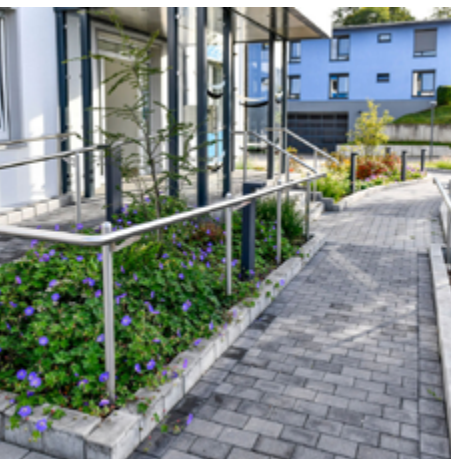
Gegenläufige normgerechte Rampe mit Randsteinen als Radabweiser
