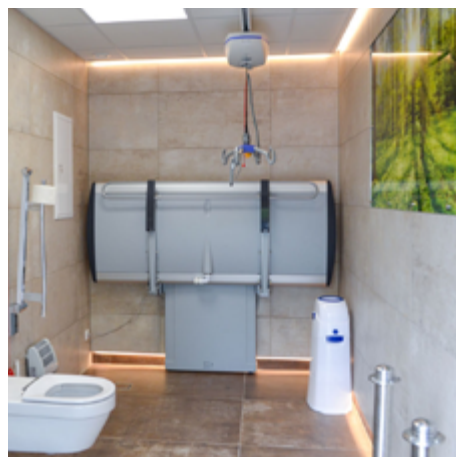
Toilette für alle mit Decken-Lifter und elektrisch höhenverstellbarer Klappliege
