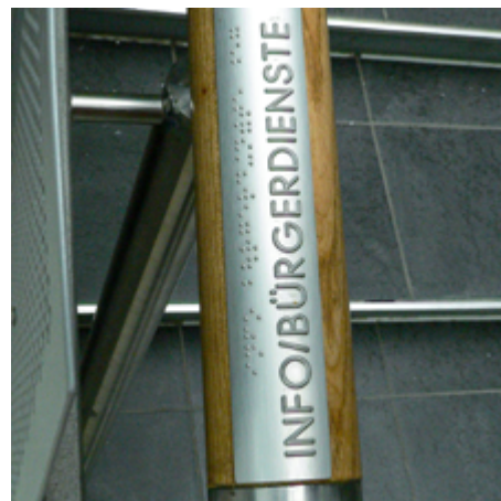
Handlaufinformation mit detaillierter Zielangabe in Braille- und Profilschrift, entsprechend DIN 32986
