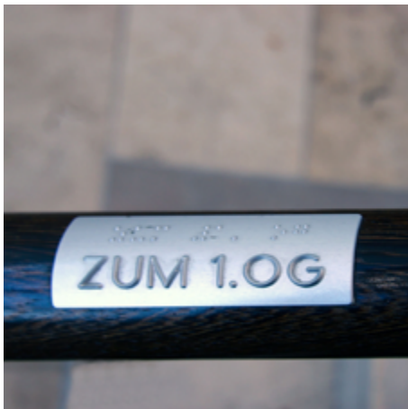
Stockwerksangabe mit Braille- und Profilschrift, entsprechend DIN 32986
