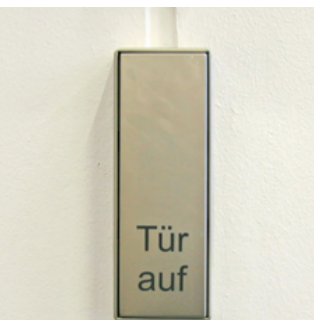
Großflächiger Öffnungstaster für eine Automatiktür. Ein ergänzendes Piktogramm wäre wünschenswert
