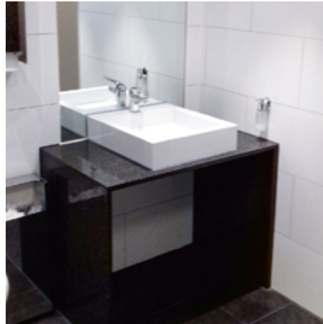
Kontrastreicher unterfahrbare Waschtisch auf Marmorplatte. Der Spiegel ist auch im Sitzen einsehbar.
