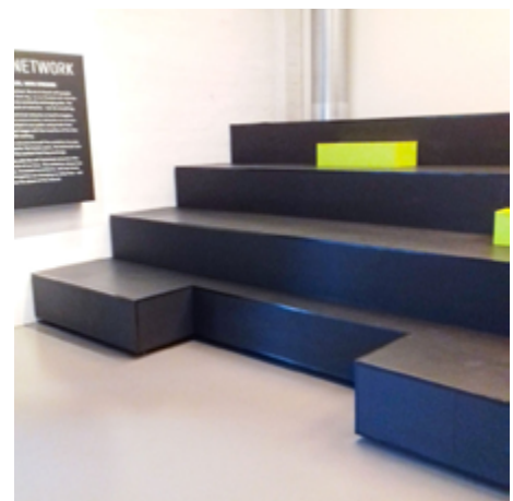
Ausgesparter ebenerdiger Bereich für Rollstuhlnutzende im abgetreppten Sitzbereich eines Museums
