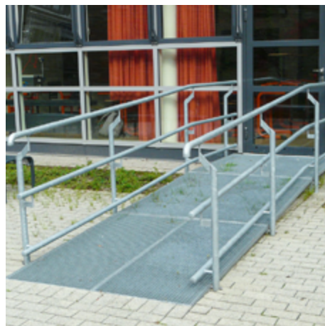
Rampe mit feinmaschigem Gitterrost, somit auch für Personen mit Gehhilfen geeignet
