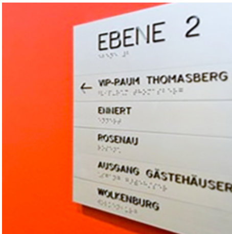
Taktiler Geschossschild mit Profilschrift und Brailleschrift
