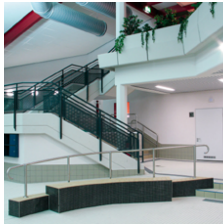
Kombination von Rampe, Geländer und Sitzgelegenheit in einem Schwimmbad. Es fehlt allerdings der 2. Handlauf.
