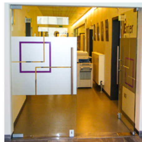
Großformatige grafisch-farbige Glasmarkierung an einer Ganzglastür
