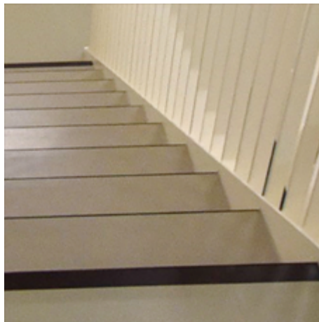
Seitliche Begrenzung der Trittstufen durch eine Blechaufkantung verhindert das Abrutschen von Gehhilfen.
