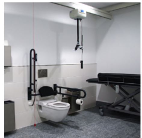
Toilette für alle mit Decken-Lifter und mobiler höhenverstellbarer Liege
