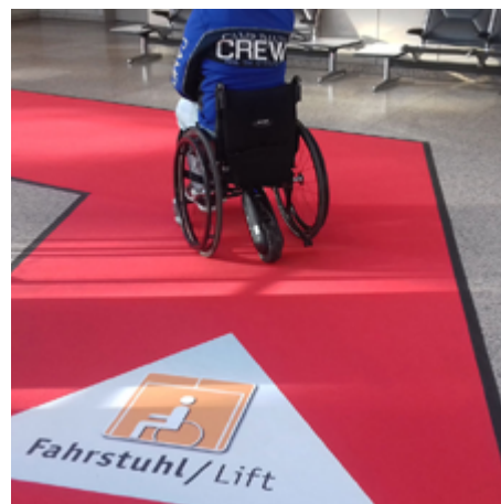
Ein tastbarer und kontrastreicher Teppichläufer kann auch als Leitlinie gelten, wie hier in einer Messehalle.
