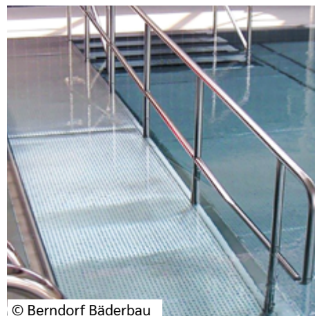
Flache Rampe mit einseitigem Handlauf und rutschfester Oberfläche
