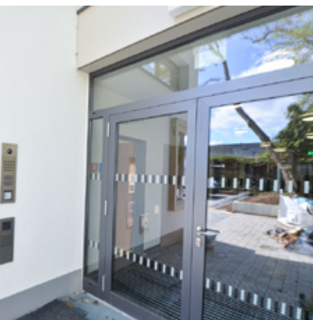
Barrierefreie Gegensprechanlage mit ausreichend Abstand zur Tür und Lautsprechern in zwei Höhen
