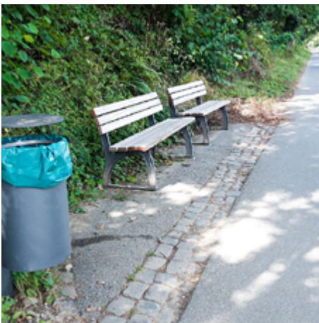
Sitzbänke außerhalb der Laufzone, taktil erfassbar durch unterschiedliche Gestaltung der Wegbegrenzung
