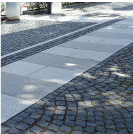
Dieser Gehweg ist kontrastreich, erschütterungsarm berollbar und mit einem Langstock gut ertastbar.
