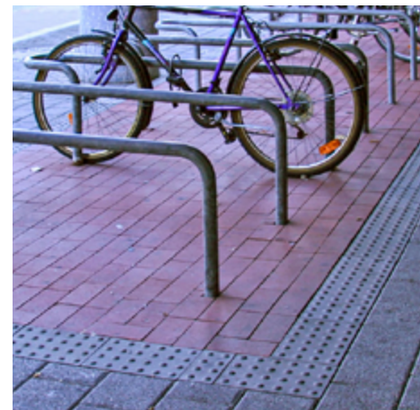
Fahrradständer mit tastbarem Aufmerksamkeitsstreifen umrandet (Streifen mit 20 cm aber zu schmal)
