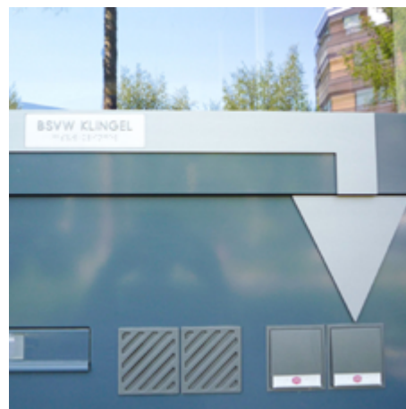
Taktile Elemente weisen den Weg zur Klingel des Blinden- und Sehbehindertenvereines in Dortmund
