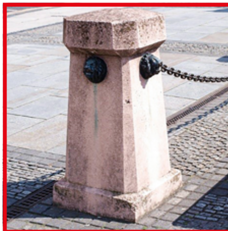
Nicht tastbare Absperrkette an einem Steinpoller auf einem Platz kann von blinden Menschen unterlaufen werden.
