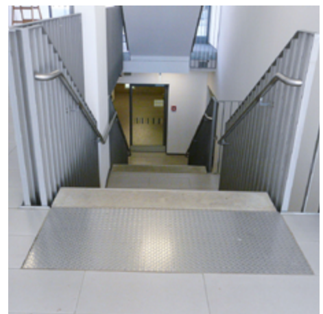
Das gut tastbare Aufmerksamkeitsfeld aus Tränenblech erfüllt auch die Anforderungen an die Rutschfestigkeit
