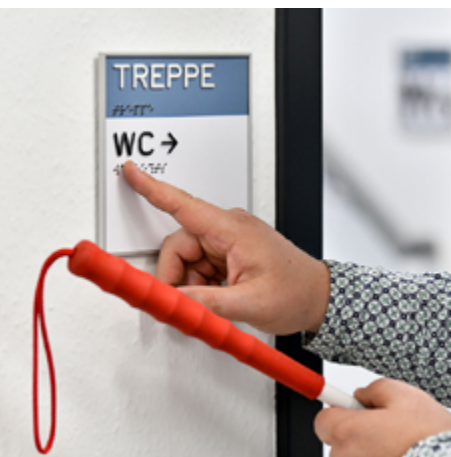
Kontrastreiches Türschild weist mit Braille- und Pyramidenschrift auf Treppenhaus und WC hin
