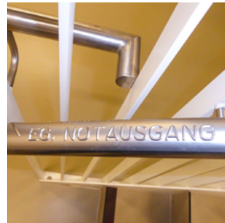
Taktile Handlaufinformation mit Richtungsangabe zum Notausgang in Profilschrift und Brailleschrift
