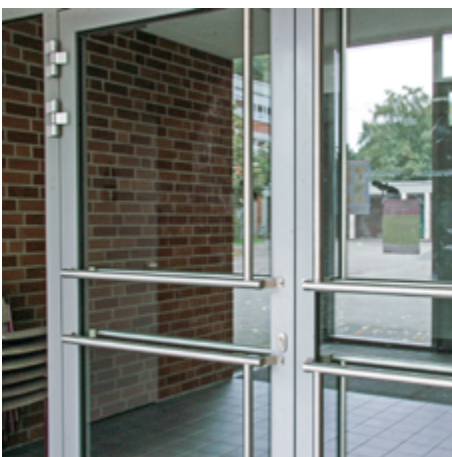
Die Griffstangen verlaufen über die gesamte Türbreite und –höhe und sind für alle Körpergrößen gut greifbar
