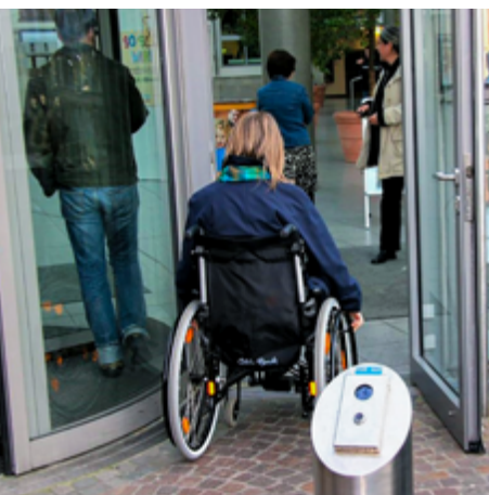
Automatiktür mit Öffnungstaster als alternativer Zugang zur Karusselltür
