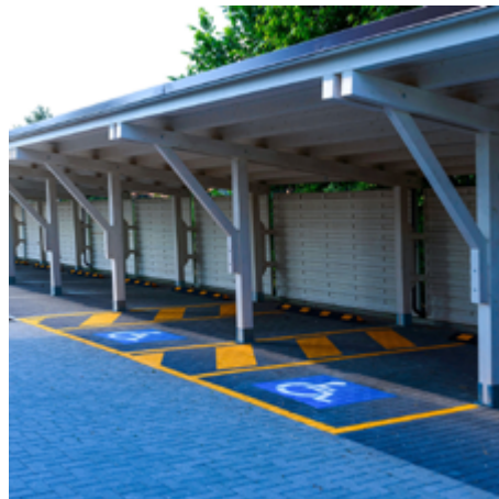
Barrierefreie überdachte PKW-Stellplätze
