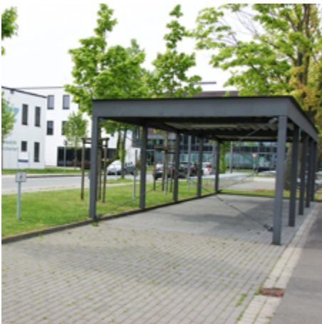
Barrierefreie PKW-Stellplätze, zum Teil überdacht
