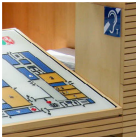
Tastplan am Infotresen im Detail; die Notausgänge sind mit Pfeilen markiert und in der Legende erklärt
