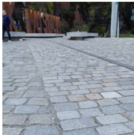
Gehstreifen mit abgeschliffenem, besser berollbarem Kopfsteinpflaster
