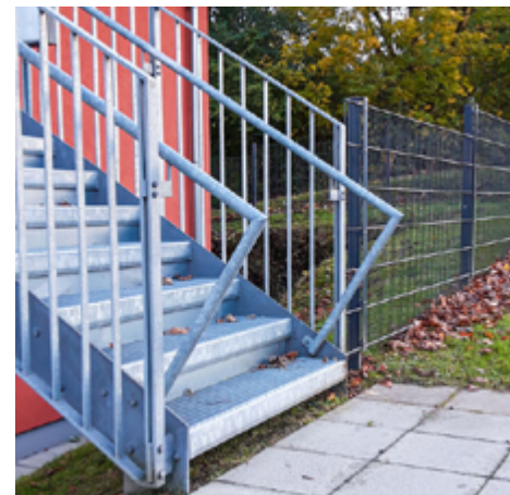
Fluchttreppe aus einer Wohngruppe mit am Ende fortgeführtem und geschlossenem Handlauf
