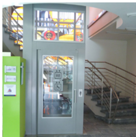
Der Plattformaufzug wurde mit einem Schacht nachträglich in ein rundes Treppenauge montiert.
