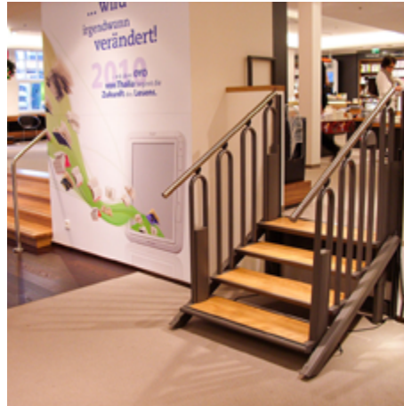
Diese platzsparende Lifttreppe für geringe Höhenunterschiede vereint Treppe und Hubplattform in einem.
