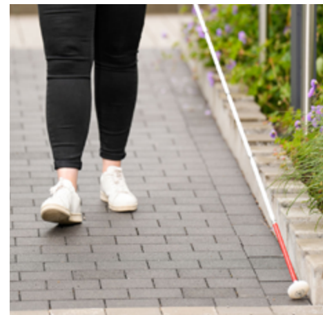
Die seitliche Aufkantung am Weg ist ausreichend hoch, um den Langstock zu leiten.
