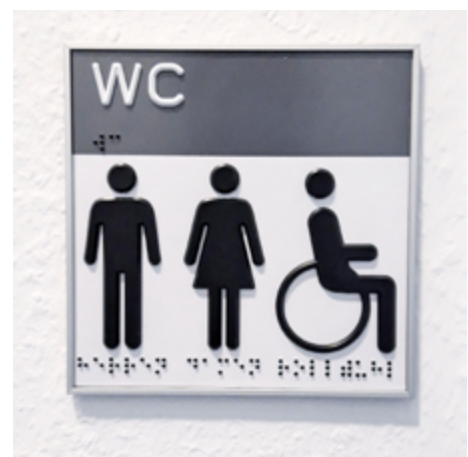
Kontrastreiches und taktiles WC-Schild mit Pyramidenschrift, Brailleschrift und Piktogrammen
