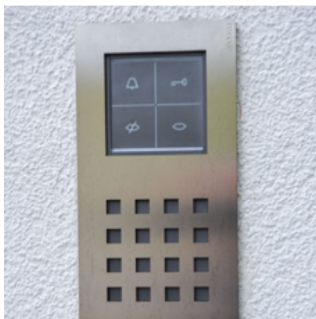
Detail Gegensprechanlage: optische Anzeige für Klingel, Freigabe Türöffner, Hörbereitschaft der Gegenseite
