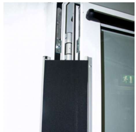
Schutzvorrichtung im Scharnierbereich einer Automatiktür verhindert Verletzungen durch Quetschungen
