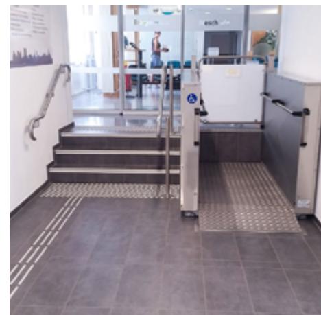
Hubplattform zur Überwindung von geringen Höhenunterschieden in einem bestehenden Bürgerzentrum
