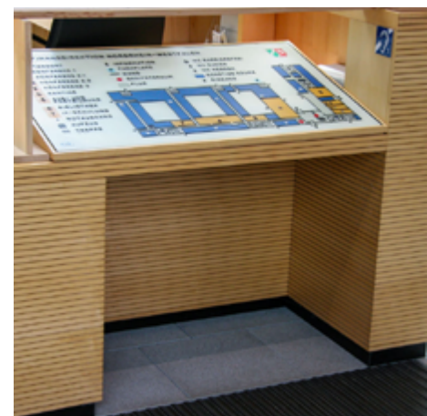
Unterfahrbarer taktiler Übersichtsplan im Infotresen mit Angaben in Profil- und Brailleschrift
