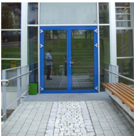
Eingang kontrastreich, mit Leitstreifen aus Kleinpflaster und tastbarem Gitterrost im Aufschlagbereich
