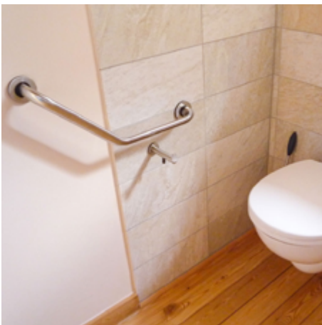
Ergonomisch sinnvoller Haltegriff mit waagrecht und schrägem Greifbereich in einer Standardtoilette
