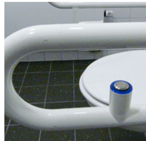
Stützklappgriff mit blau markiertem Spülknopf
