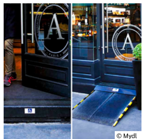
Diese Einbaurampe kann bei Bedarf ausgezogen werden. Ein Rollstuhl-Symbol weist auf diese Möglichkeit hin.
