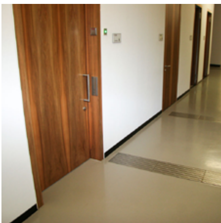
Schiebetür eines barrierefreien WC mit Auffindestreifen, elektrischem Türöffner und Besetztanzeige
