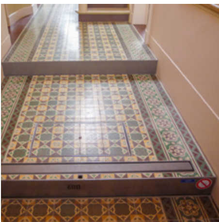
Als vordere Absturzsicherung dient eine Aufkantung, die nur bei Bedienung der Hebebühne hochfährt.
