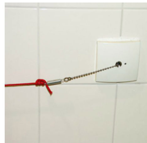
Horizontaler Notruf-Seilzug - Detail Rufmodul
