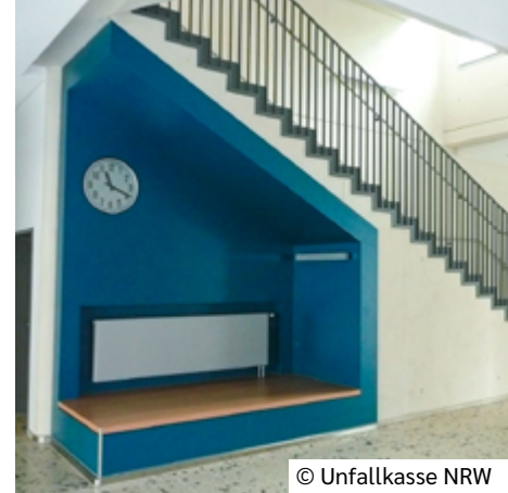
Treppenunterkante abgesichert durch eine tastbare und kontrastreiche gestaltete Sitzecke
