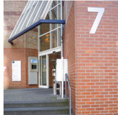
Gebäude mit großer und kontrastreicher Hausnummer
