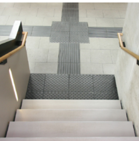
Aufmerksamkeitsfeld am unteren Treppenantritt mit Noppenplatten; eingebunden ins Leitsystem
