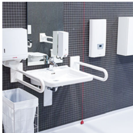
Beidseitige Haltegriffe an einem Waschtisch in einem kontrastreichen barrierefreien Sanitärraum
