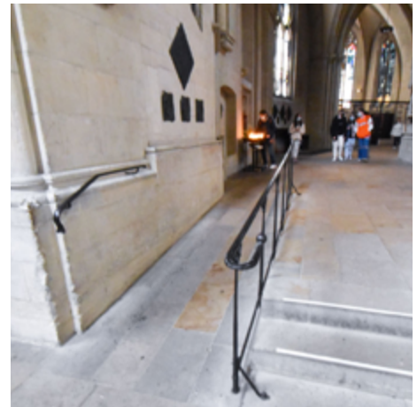
Rampen-Treppen-Kombination mit einseitigem Radabweiser im Dom von Münster
