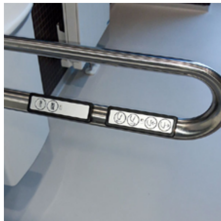
Bedienknöpfe der elektrisch höhenverstellbaren Toilette im Stützklappgriff
