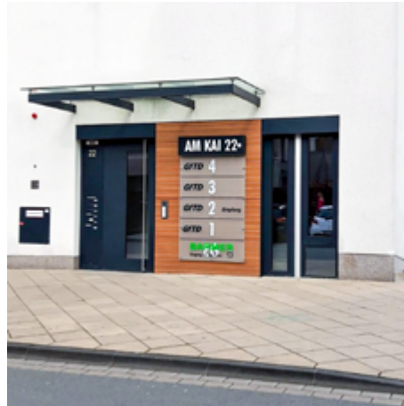
Markanter Gebäudezugang mit Vordach, von weitem gut lesbarer Adresse und Nutzung der Stockwerke
