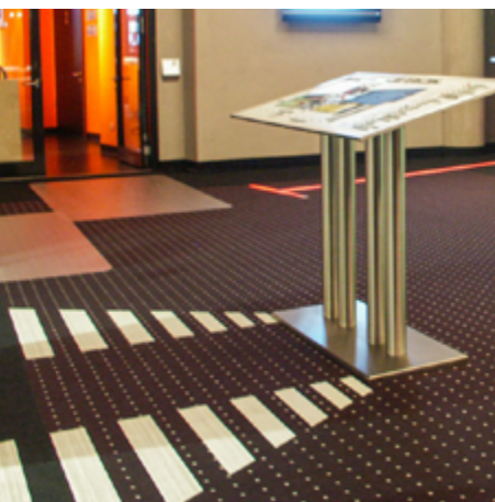
Aufgeklebte kontrastreiche und tastbare Leitstreifen leiten vom Eingang zum Orientierungsplan.
