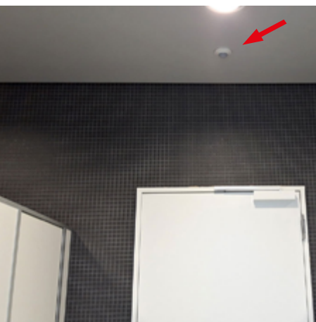
Blitzleuchte in einer Damentoilette; das Blitzsignal an der Decke ist in allen Kabinen sichtbar
