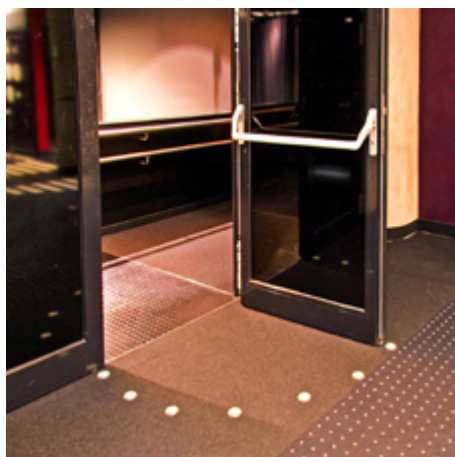
Fluchttür mit kontrastreichem Panikriegel und Markierungspunkten des Öffnungsradius auf dem Boden
