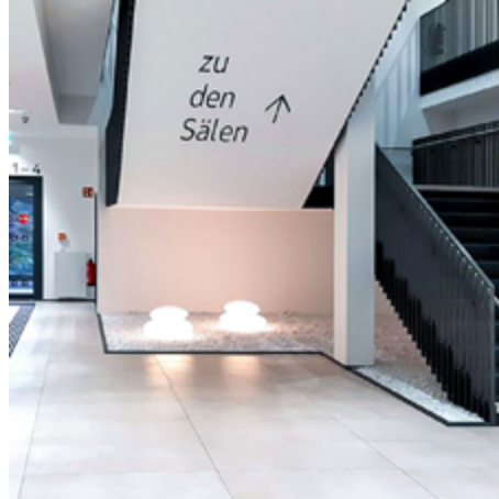
Treppenunterkante dekoriert und abgesichert durch eine kontrastreiche und tastbare Aufkantung
