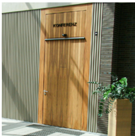
Automattür mit Bewegungsmelder; gut auffindbar durch Leitsystem, Beschriftung und taktile Unterschiede
