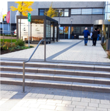
Der normgerechte Handlauf führt auf den Eingang einer Klinik zu und ist eingebunden in das Leitsystem.
